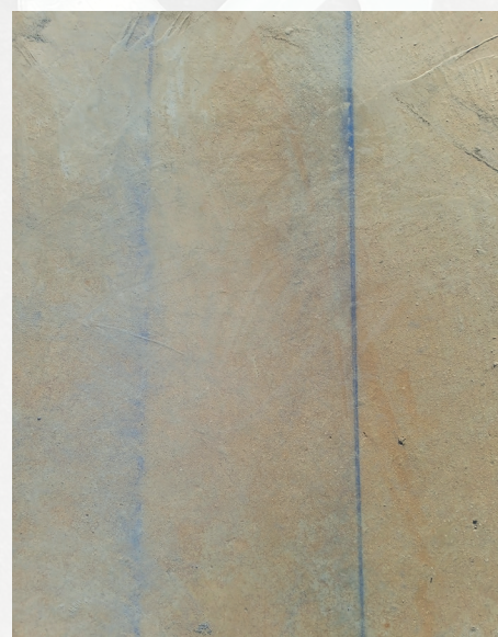
SIN FIJADOR DE AZULETE
